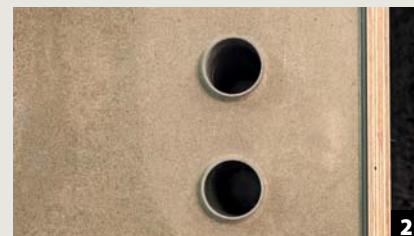
2 Optimale Verdichtung auch um Leitungspakete oder Rohre
