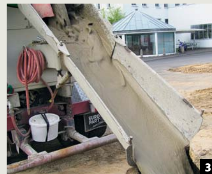
3 Schnelle und einfache Verfüllung dank fließfähiger Konsistenz
